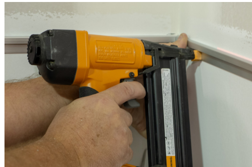
Clavos 16-18 de 1", para sujeción del perfil
