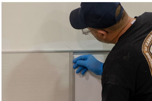
Instale el siguiente perfil
