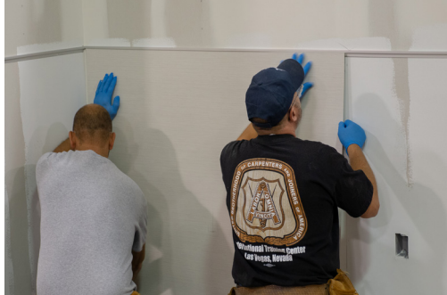
Inserte el panel en el perfil
