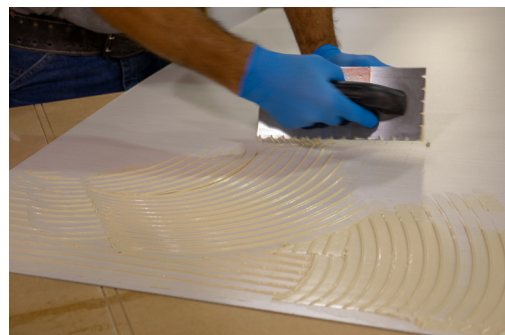
Aplique adhesivo cubriendo el 100% del reverso
