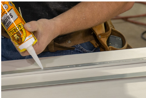
Utilice silicón transparente 100% para colocar perfil
