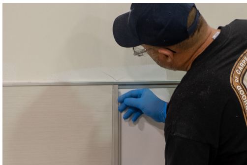
Installez la bordure suivante
