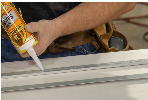
Utilisez du scellant transparent 100 % silicone pour que la bordure adhère bien.
