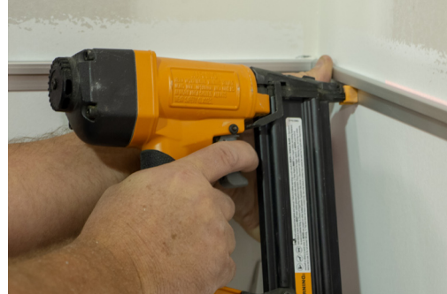
Utilisez des clous de calibre 16-18 et d'une longueur de 1 po (25,4 mm).
