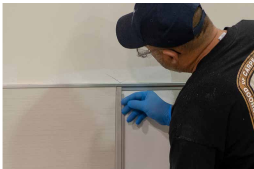
Installez la bordure suivante
