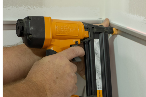
Utilisez des clous de calibre 16-18 et d'une longueur de 25,4 mm (1 po).
