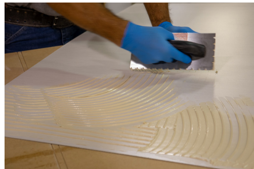
Appliquez l'adhésif. La surface doit être entièrement recouverte d'adhésif.
