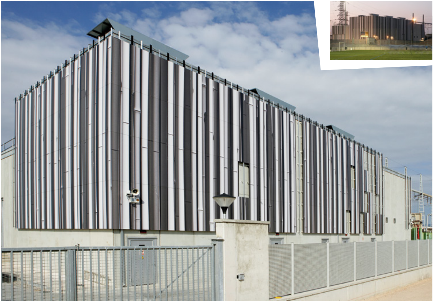
Transformer Substation Beniferrí-Valencia. Tomás Llavador Arquitectos+Ingenieros.
