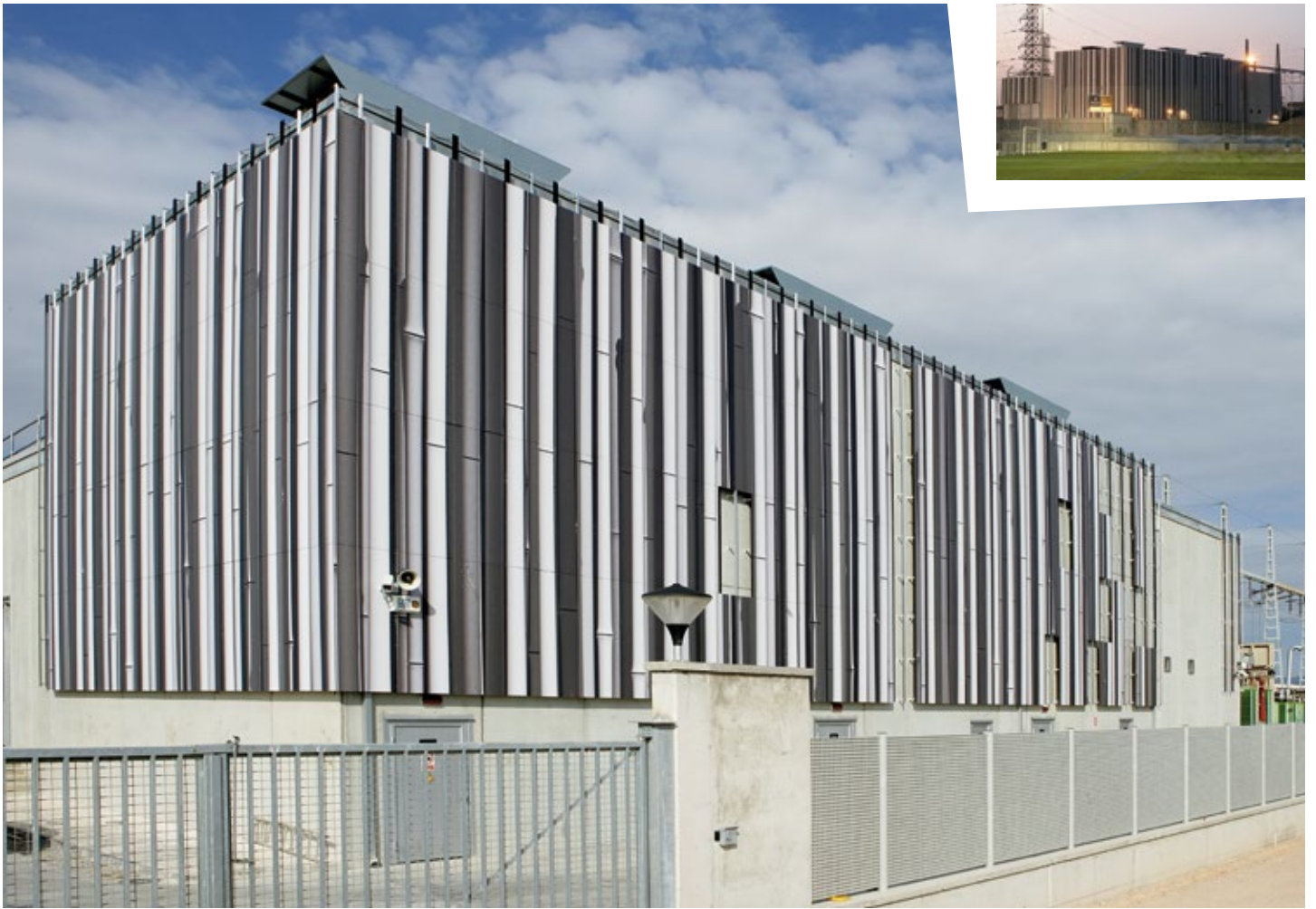
Transformatorstation i Beniferrí-Valencia. Tomás Llavador Arquitectos+Ingenieros.
